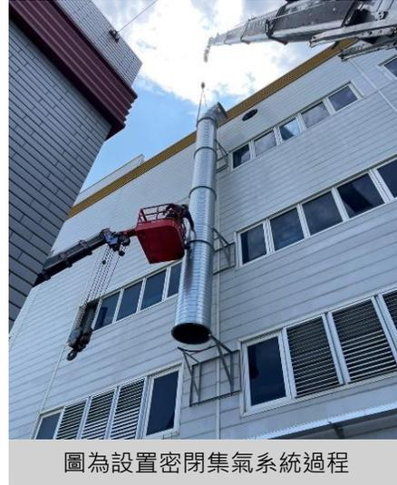
圖為設置密閉集氣系統過程
